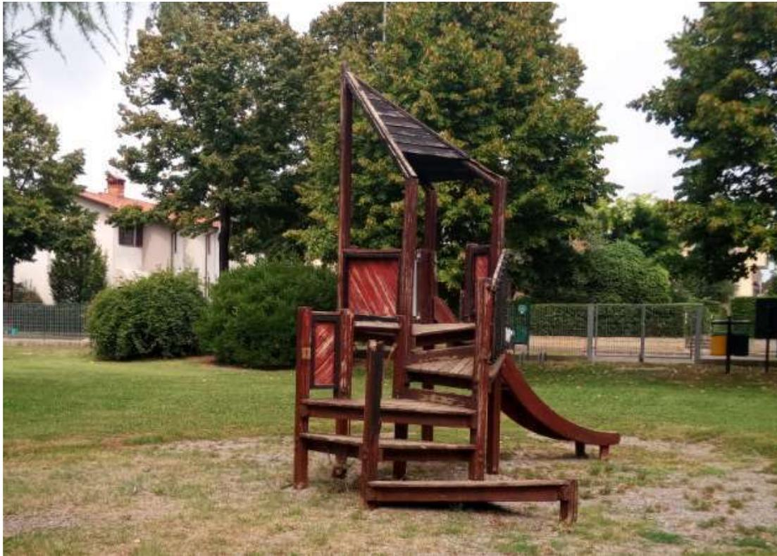
*Foto 7 - Dettaglio degrado materiali e instabilità accesso al castello in legno*
